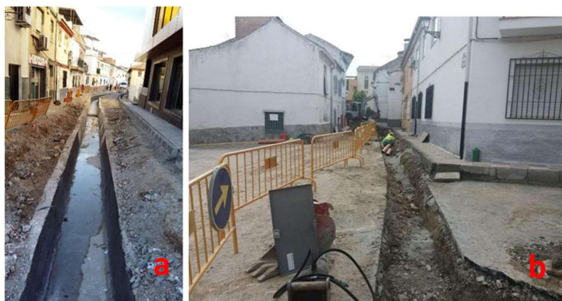
Lámina 9. a) trazado de la acequia principal proveniente del río Dilar hacia Gabia la Grande a su paso por el casco urbano de Alhendín, durante las obras de remodelación de la calle Vereda de la Acequia.
