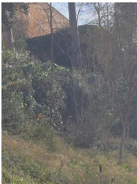
Lámina 22. Exterior de la torre del Carril desde la Alameda. (C.Vílchez, 2023).
