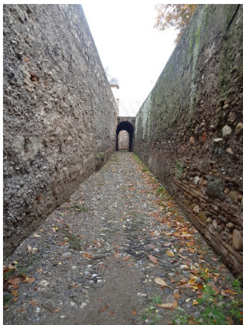
Lámina 19. Foso que va desde la puerta del Carril hasta la puerta de Siete Suelos. (C. Vílchez, 2025).
