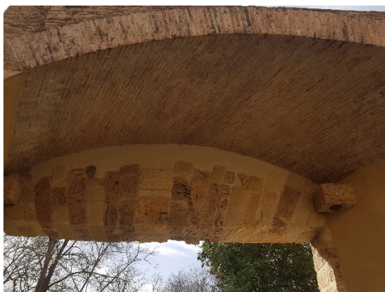
Lámina 14. Gorronera y bóveda rebajada de la puerta. (C. Vílchez, 2025).
