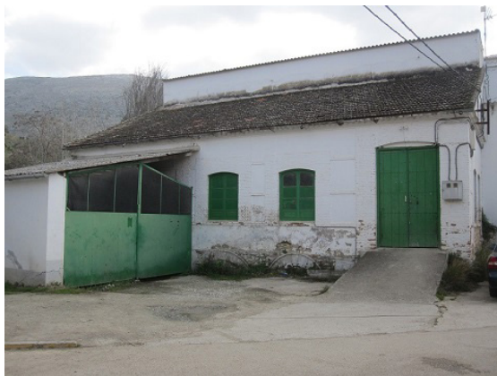
Lámina 11. Fábrica de Harina de Mengotti/ Fábrica de la Luz (foto autor).
