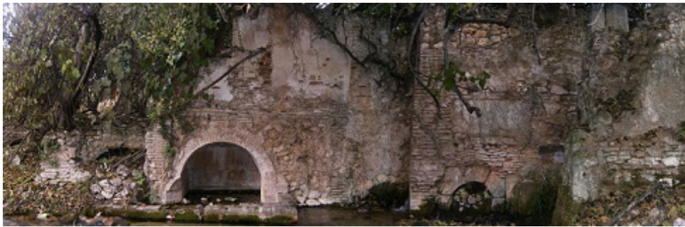
Lámina 6. Exterior del Martinete de Riofrío de su molino (foto autor).
