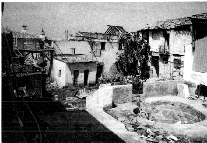
En abril de 1997, caían las últimas crujías. Éstas formaban parte de un taller de alfarería en la actual carretera de Murcia. Fot. A. Fernández Ortega
