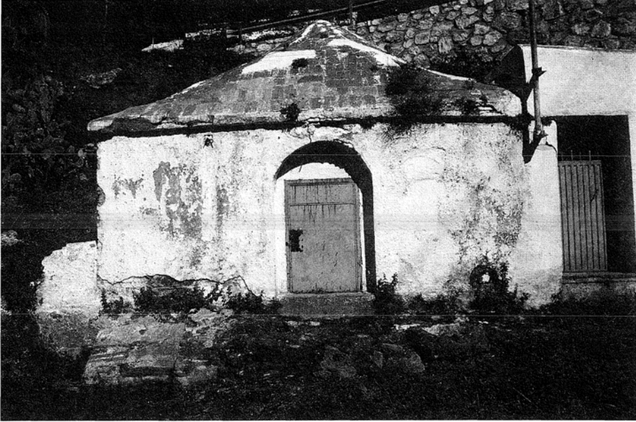
Exterior de la rábita de Arenas.
