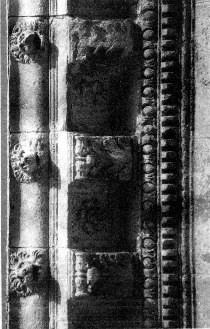
Palacio de Carlos V. Detalle de la Cornisa exterior.
