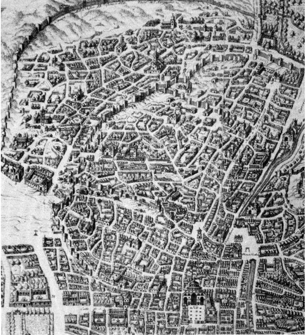
Iglesia de S. Gil. Detalle de la Plataforma de Vico, 1613. La Iglesia Parroquial de S. Gil lindando con las casas que conformaban una manzana en la estructura urbana de Plaza Nueva.
