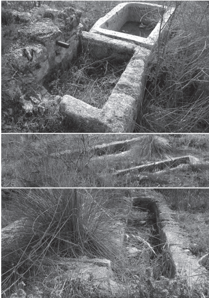
Figura 4. Infraestructuras hidráulicas de las inmediaciones de Los Alcachofares (Íllora)
